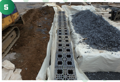
再び土木シートを敷き、スーパージオ®を設置します。
