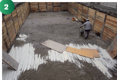
土木シート敷設、碎石敷設します。
