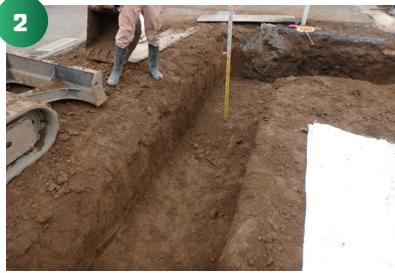
根伐り、掘削を行います。
