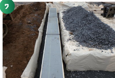
Rボード設置を行います。
