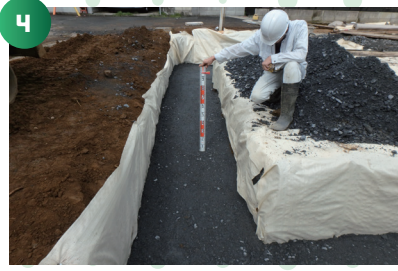
碎石を敷設（ふせつ）し、転圧を行います。
