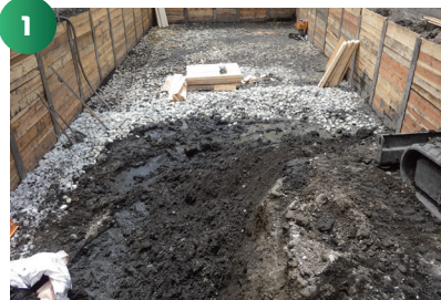
根伐り、掘削を行い、割栗石敷設します。
