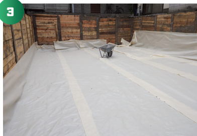
梱包用土木シート敷設します。
