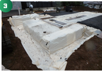
土木シートを敷きます。
