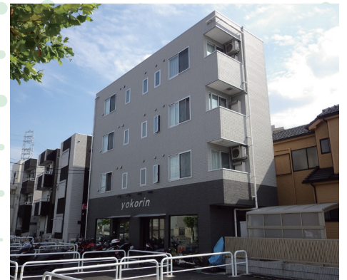
弘道店舗付共同住宅(東京都足立区) 構造規模:鉄骨造 地下1階地上4階建て
