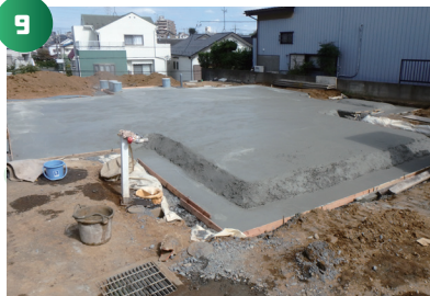
捨てコンクリート打設して工事完了です。
