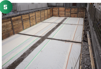
土木シートにてスーパージオ®を梱包し、隙間は碎石で埋め戻します。
