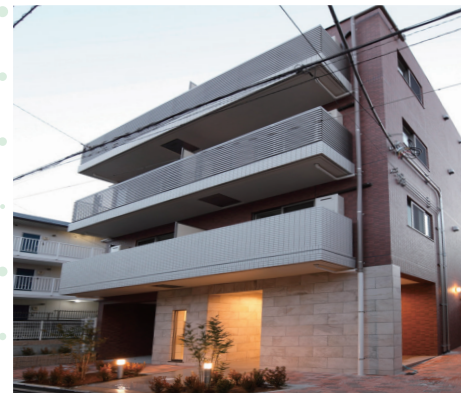
押上マンション(東京都墨田区) 構造規模:鉄筋コンクリート造 地上5階建て
