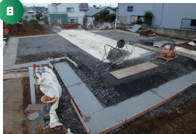
隙間など全体を碎石で埋め戻します。
